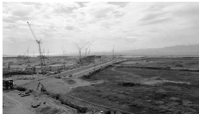
【写真2】右手に広がる雑草で覆われた部分がカジノ予定地。左手の重機が並ぶ広大な空き地が万博予定地。中央やや左に小さなヤグラのような建物が見える。これは円形通路の一部。
